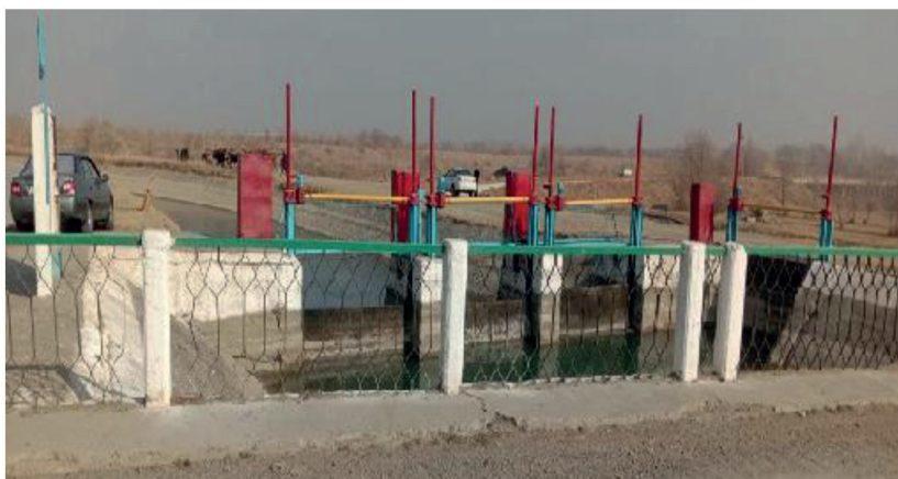
Рис 1. Водовыпускной шлюз джизакского водохранилища
